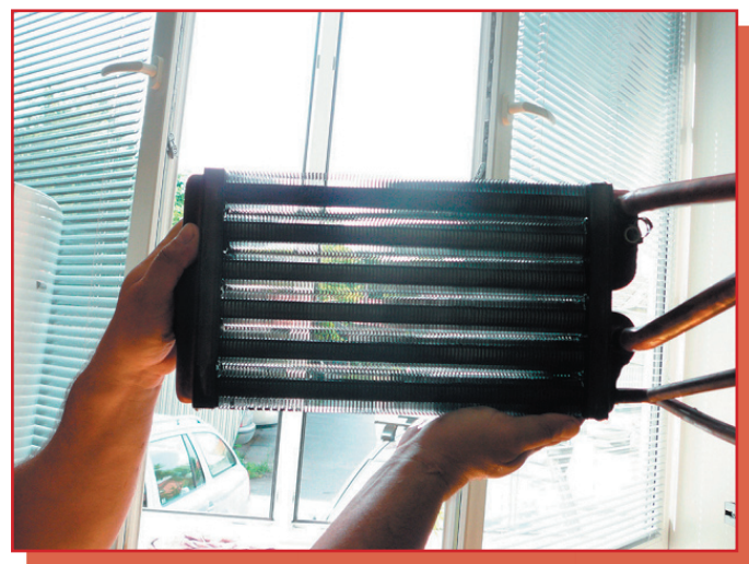
Obr. 7 – Pohled proti světlu na výměník po vyčištění lamel výměníku
